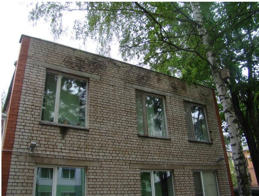
2.att. Ēkas gala siena. Redzami ķieģeļa mūra bojājumi mitruma iedarbības dēļ
