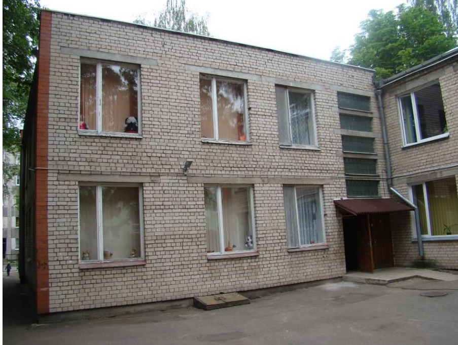
1.att. Ēkas fasādes siena. Ēkas fasādes ārsienas veidotas no ķieģeļa mūra 510 mm biezumā. Ārsienas kopumā ir apmierinošā stāvoklī, tomēr to siltuma caurlaidības koeficients ir augsts.
