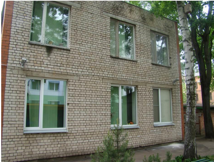
3.att. Ēkas fasādes ārsienas daļa. Daži ēkas logi ir nomainīti pret jauniem pakešu logiem PVC rāmjos. Vecu logu stāvoklis vērtējams kā neapmierinošs
