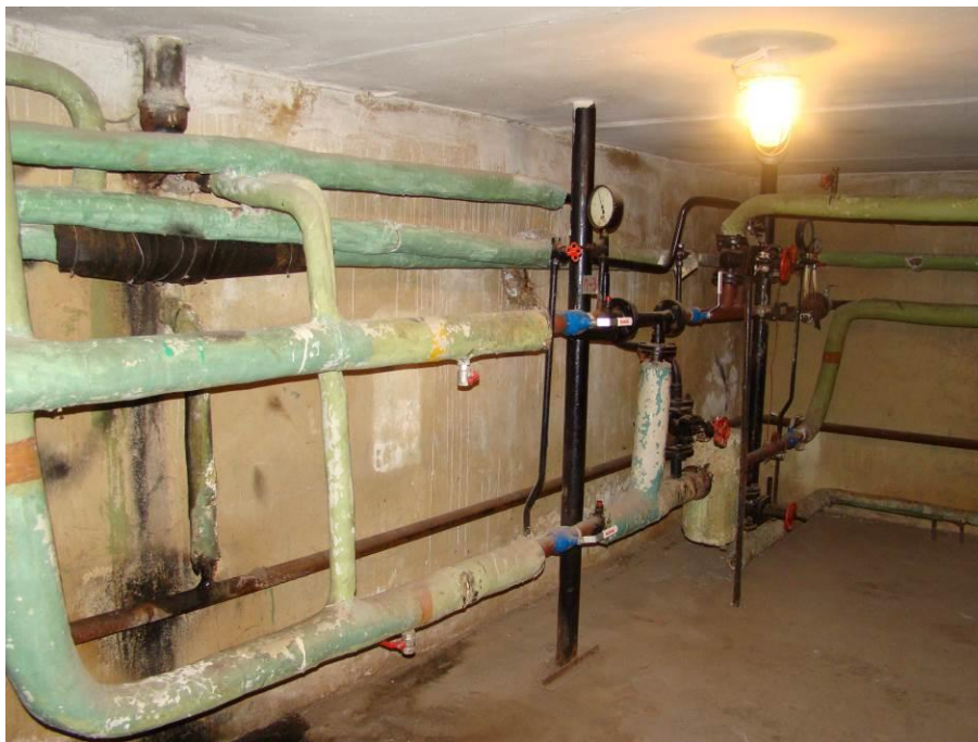
6.att. Ēkā uzstādīts vecs siltummezgls..
